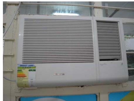
幼稚園安裝一級能源標籤冷氣機
