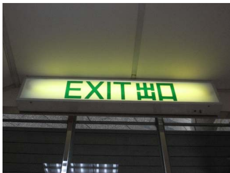
幼稚園二極管出路燈安裝
